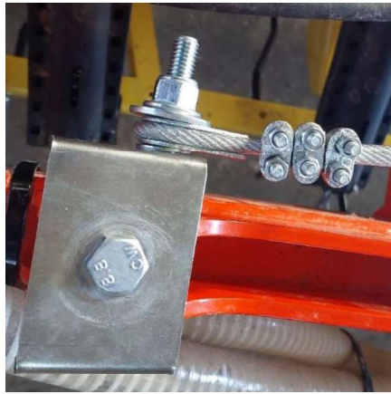
Abbildung 12: Anbringen des Seils an der Schraube des Blechprofils
